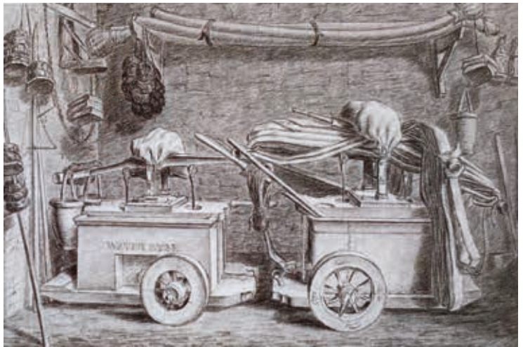
▲ Tekening uit 1838 van een brandspuit met benodigdheden, opgeslagen in een brandspuithuisje. In veel dorpen stonden één of meerdere brandspuithuisjes waar de brandblusapparatuur in staat van paraatheid werd gehouden, zoals blijkt uit de gemeentelijke verslagen.
