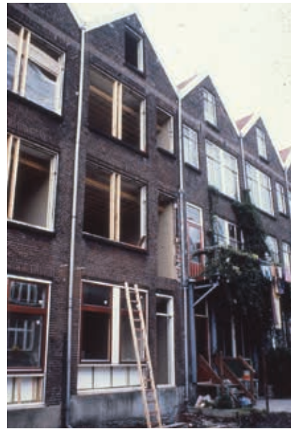
◀◀ Sloopwerk in Crooswijk. Foto Stadsarchief Rotter- dam/Ary Groeneveld
