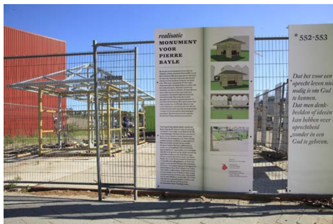
Het monument in aanbouw
