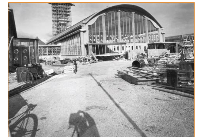
Rivierahal in aanbouw, 1940 met slagschaduw van fotograaf Gerrit Burg, linksachter de uitkijktoren in de steigers. (Gerrit Burg/HNI Rotterdam)
