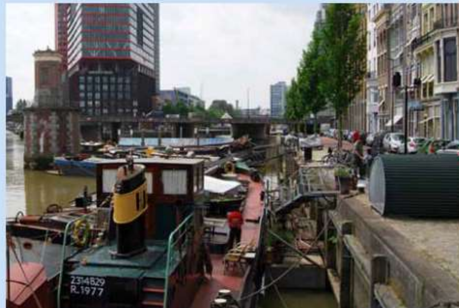
Wijnhaven (ten oosten van de Verlengde Willemsbrug), 2013
